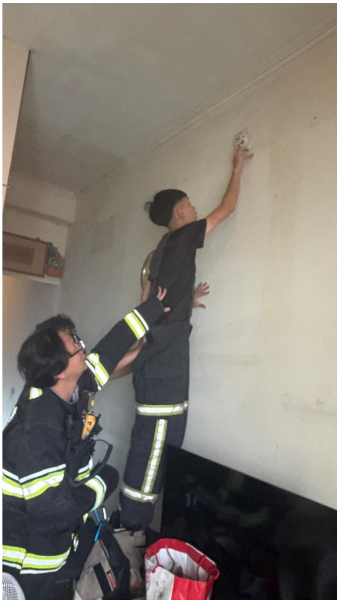
圖二：鄰居家中住警器安裝處
