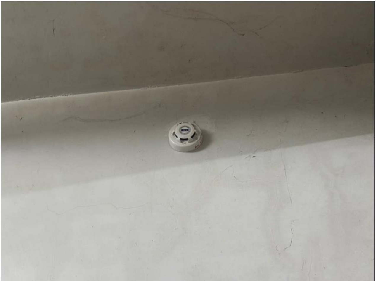
圖三：住警器裝設位置(廚房牆壁)
